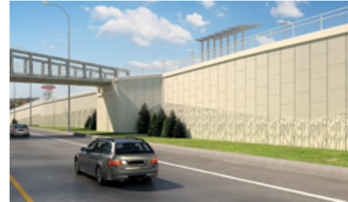
Murs de soutènement et culées
