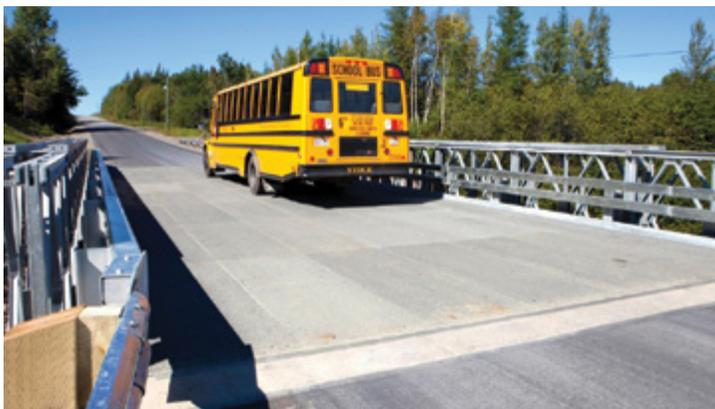
**Ponts modulaires de treillis rivetés Algonquin**
