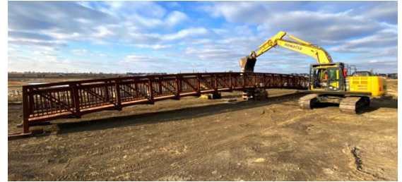
Le pont piétonnier a été livré en deux sections et assemblé sur place
