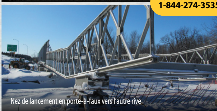
Mise en place à partir d'un côté sans matériel de levage
