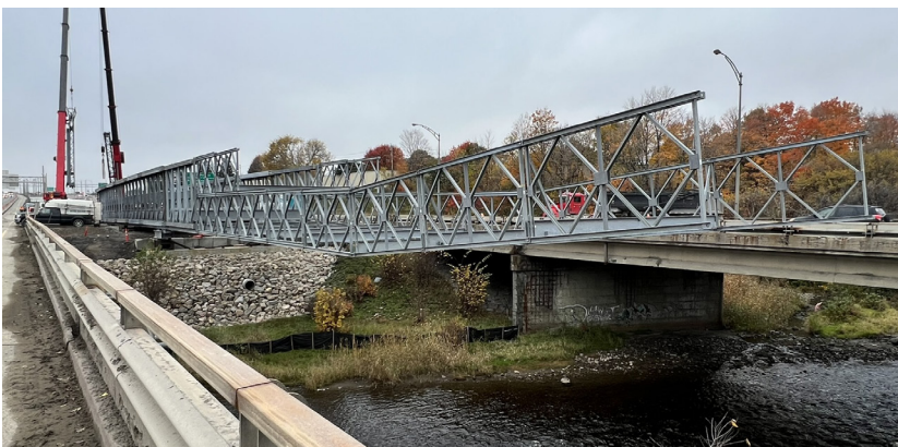
Mise en place en porte-à-faux d'un système modulaire en treillis riveté au-dessus de la rivière Saint-Charles
