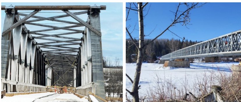
Le pont existant (à gauche) a été démantelé et le nouveau pont (à droite) a réutilisé les piles et culées existantes
