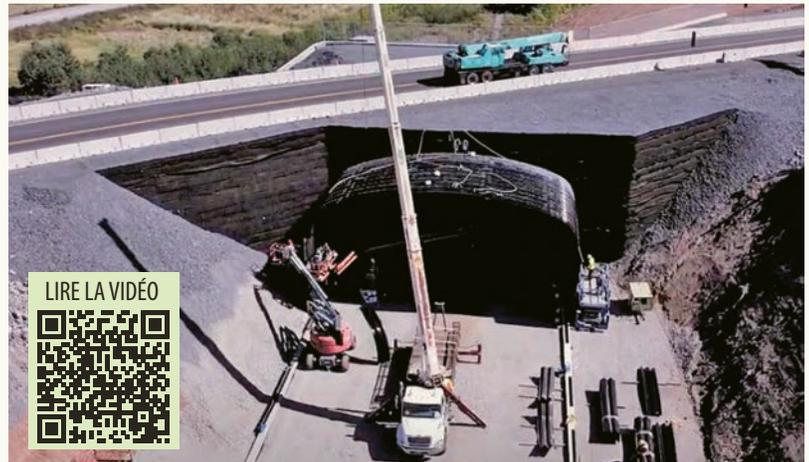
**Maintenir la circulation :** la construction par étapes avec des murs TSM temporaires permet aux véhicules de continuer à circuler pendant toute la durée des travaux.
